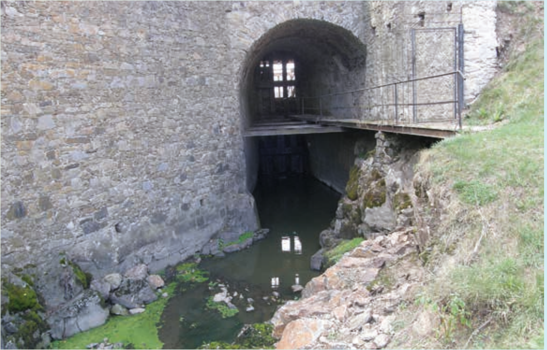
Klenutá výpust rybníka Dvořiště vysekaná ve skále. Foto: Miroslav Čeněk
