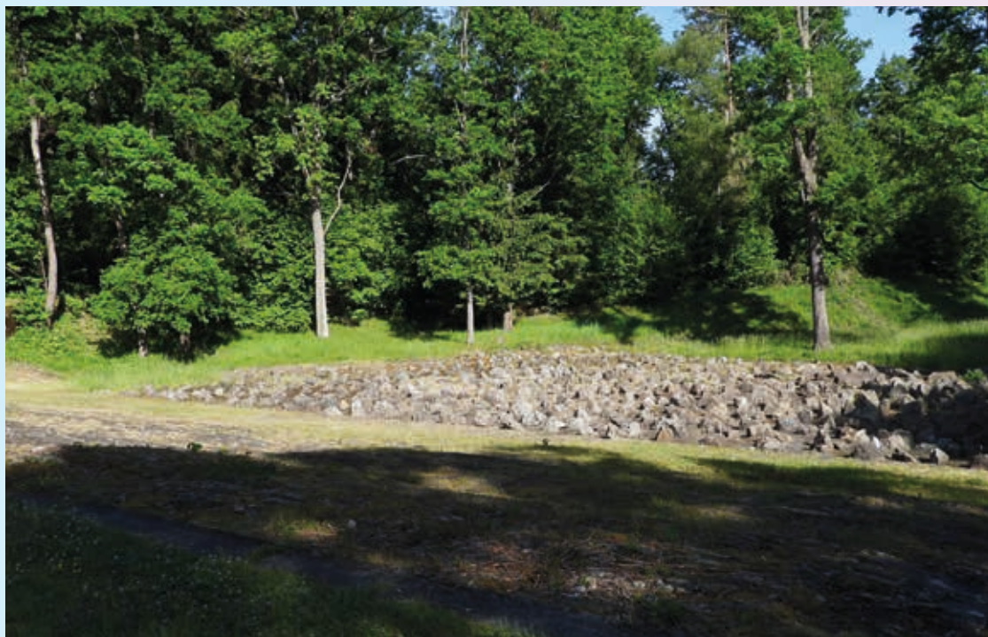
Vývařiště u rekonstruovaného splavu Rožmberka v letech 2003–2004. Foto: Miroslav Čeněk
